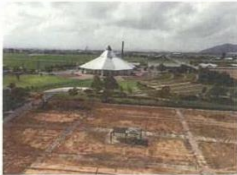
ゆりの里公園の現状(H28.7月現在) 公園部改修工事
