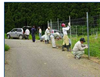
【耐雪型侵入防止柵の設置】
