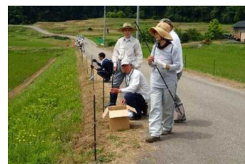
【ボランティアによる電気柵設置】
