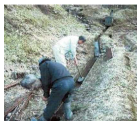
【定期水路点検・江ざらい】
