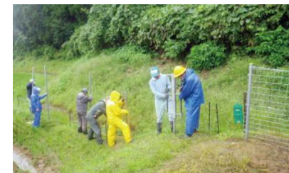
【耐雪型侵入防止柵の設置】
