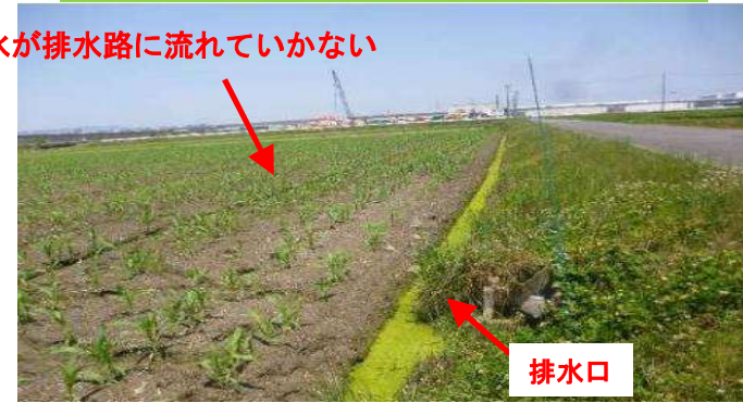
排水路の高低差がないため排水不良（逆流）
