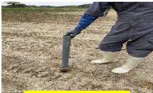
地下水位を測定するため設置
