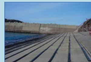
岸壁等の軽労化施設
