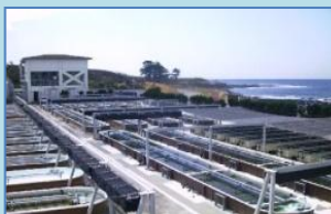
魚類・貝類種苗生産施設
