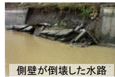
側壁が倒壊した水路
