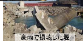
豪雨で損壊した堰
