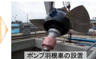
ポンプ羽根車の設置
