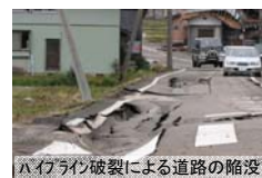
パイプライン破裂による道路の陥没
