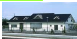
集落排水施設
