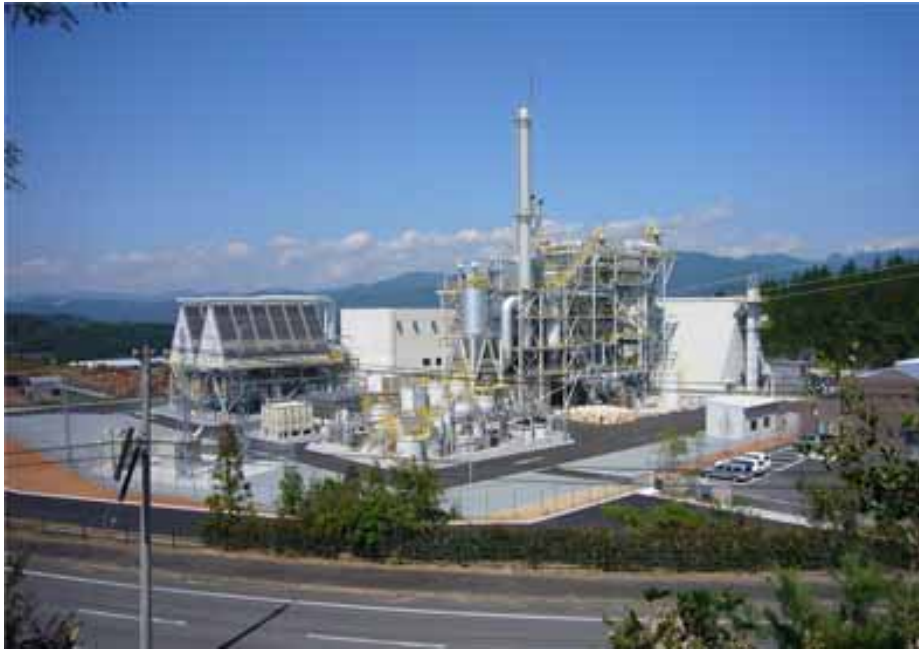
図 2-13 日田発電所の外観
