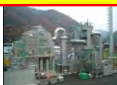
発電施設の改良
