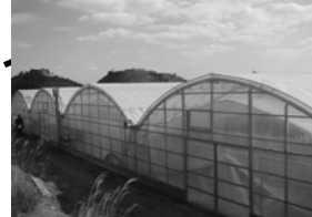
小水力発電に対応した省エネルギーモデル温室
