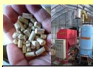
木質ペレット・ボイラー
