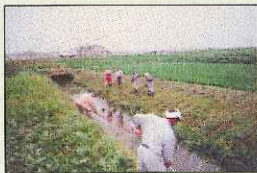
水路の泥上げ
