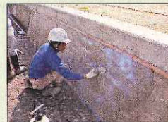
水路の補修・更新
