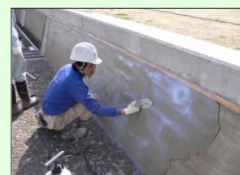
水路の補修・更新
