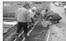
水路の補修 (施設の長寿命化)
