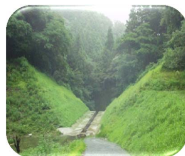
ため池の廃止（堤体の切開） [写真は堤内側から撮影]
