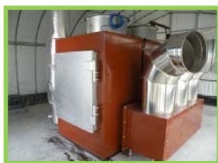
木質バイオマス利用加温設備 燃油削減率 ほぼ100%
