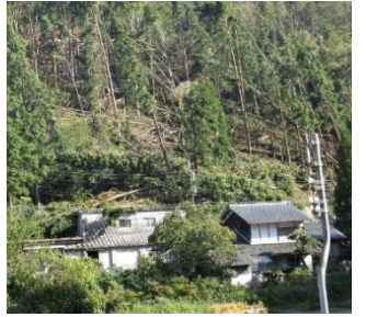
台風による民家裏の倒木被害（京都府）
