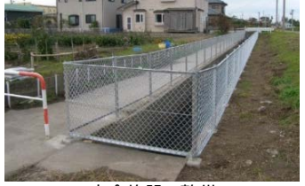
安全施設の整備
