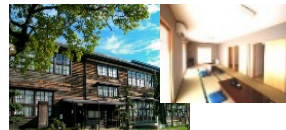
廃校を改修した大規模滞在施設
