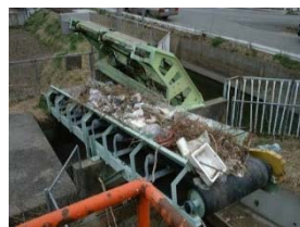
除塵機の設置
