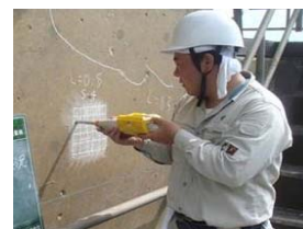
老朽化した施設の機能診断
