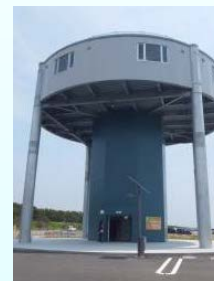
津波避難タワー
