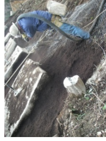
植生基材の吹付け
