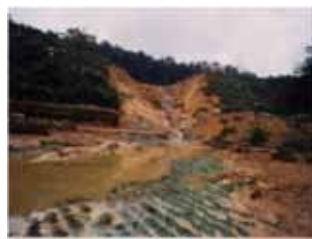
堤体が決壊し漏水したため池
