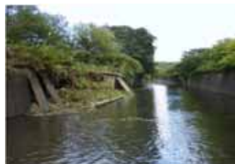
側壁が倒壊した用水路
