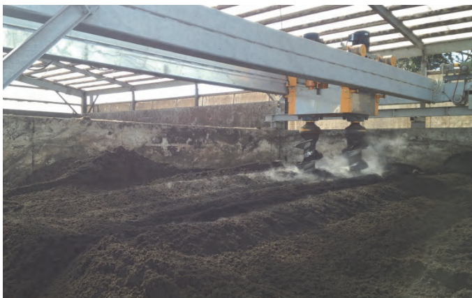
攪拌堆肥舎(スクリュー式)
