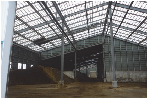
写真1 第一次堆肥処理施設
