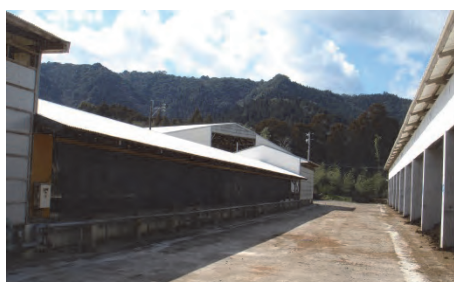
ロータリー式攪拌堆肥舎外観 (左側)
