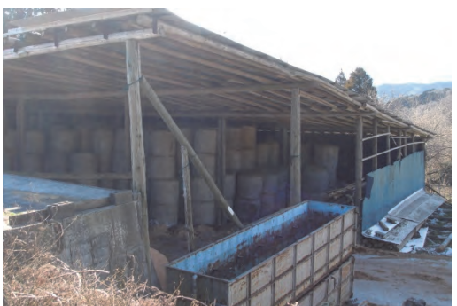
飼料・敷料保管庫
