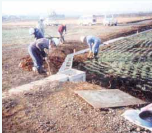
（排水路の設置作業）
