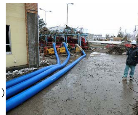
災害応急用ポンプによる排水作業（宮城県名取市）
