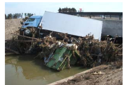
がれきの堆積した幹線排水路（宮城県名取市）
