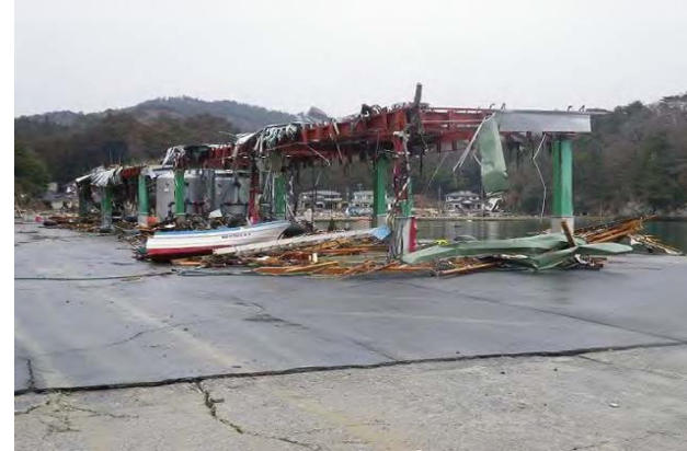
被災した養殖かき浄化施設（石巻市）
