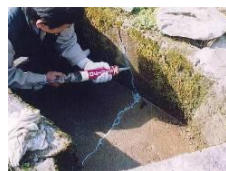
水路のひび割れ補修
