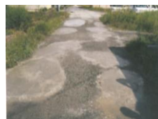
農道の窪みの補修
