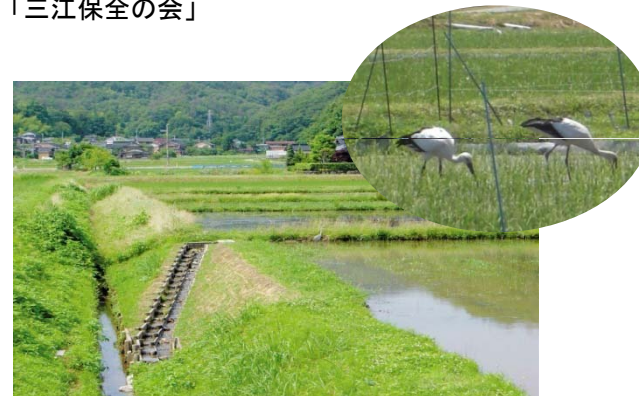
豊岡市で最初の水田魚道（木製2連型）
