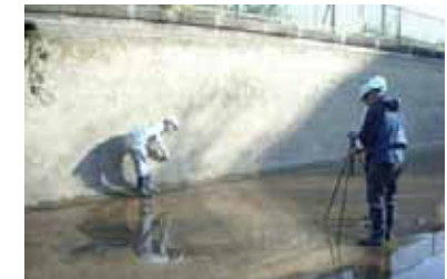
サーモグラフィによる水路壁面調査
