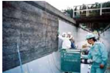
FRPM板取り付けによる断面補強
