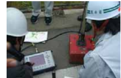
地中レーダによる埋設管調査
