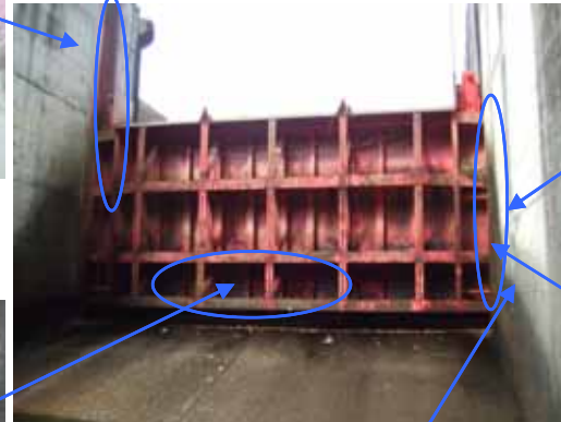
ローラとの摩耗による戸当り損傷
