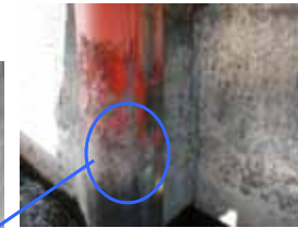
ローラとの摩耗による戸当り損傷
