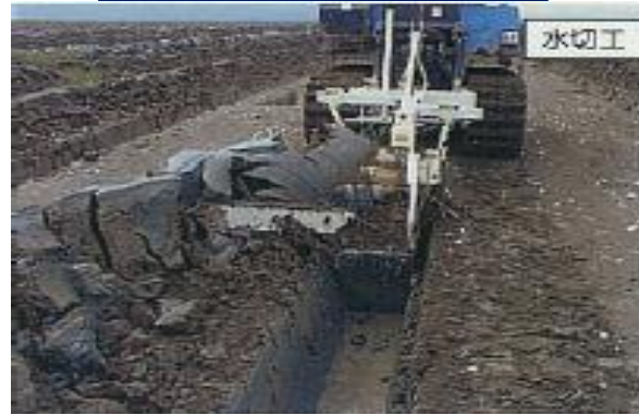
②仮排水路・水切溝の設置
