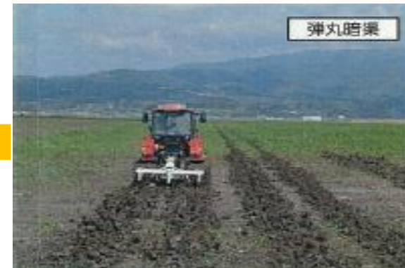
④弾丸暗渠の施工
