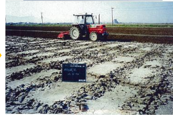
③石灰系土壌改良資材の投入
