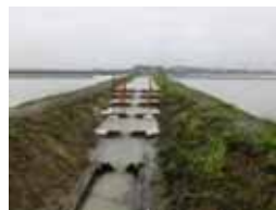
魚が遡上出来るよう排水路を改修
