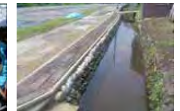
改修された釜淵堰
