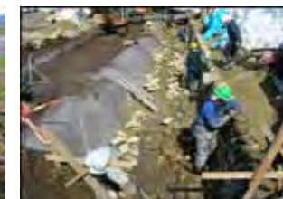
地域住民の直営施工で玉石積水路に改修(梅花藻移植)
