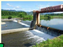
上流部の取水口を第1頭首工に統合
