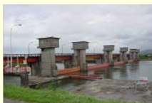
下流部の取水口を第2頭首工に統合
