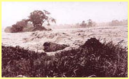
写真2 加治川の氾濫状況
