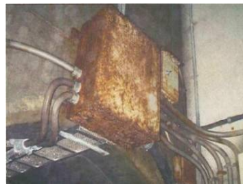
写真 21. 電気設備の劣化
