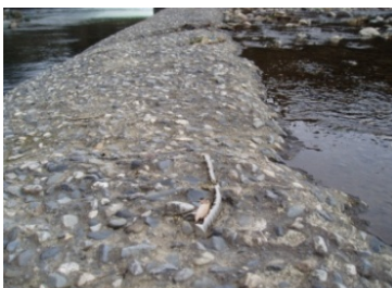
写真 22. 固定堰の摩耗 (大庄屋江頭首工)
