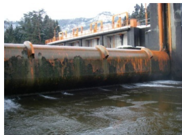
写真 23. 土砂吐ゲートの腐食 (加治川第 1 頭首工)
