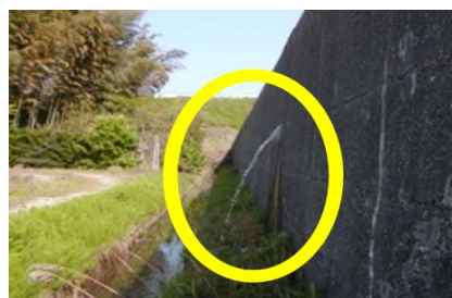
写真 26. 目地の損傷による漏水
