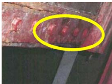
写真 20. 制水ゲートの劣化
