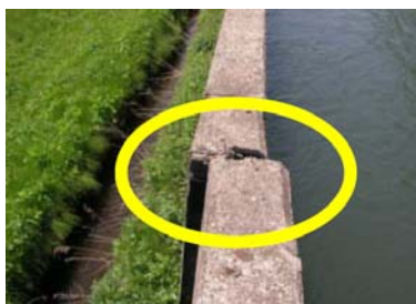
写真 25. 継目のずれ
