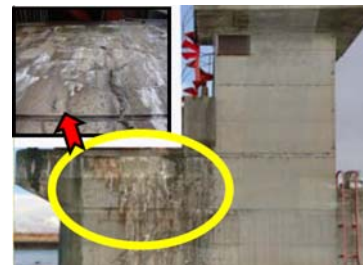
写真 24. 堰柱のひび割れ (加治川第 2 頭首工)
