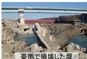
豪雨で損壊した堰
