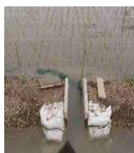
水路と水田との接続部
