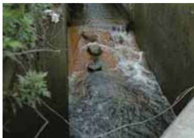
改良された魚道（片斜式粗石付魚道）
