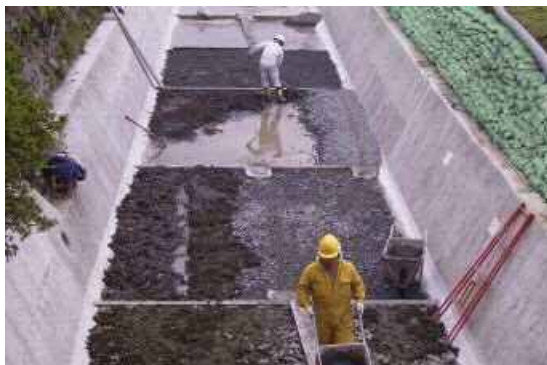
環境配慮対策施工状況
