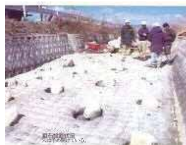
高強度マットにより形成された斜面に粗石を設置した状況
