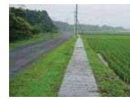
蓋が設置された水路
