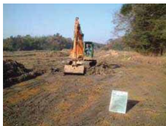
現況表土埋め戻しまでを実施
