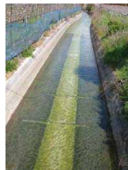
環境配慮対改善後の水路
