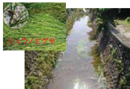
事業実施前の水路
