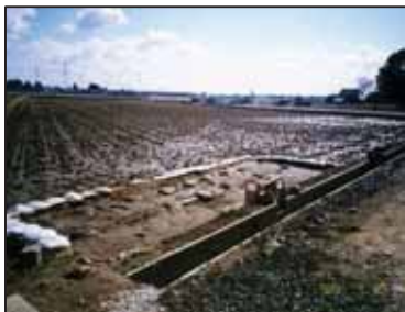
水田を借り入れ沈砂池として利用
