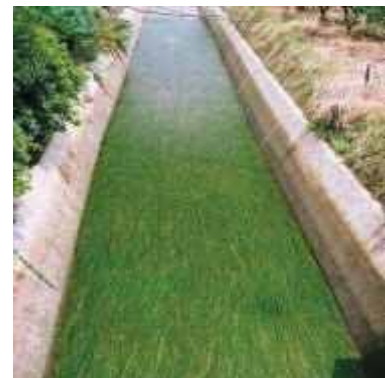
配慮対策施工後の水路
