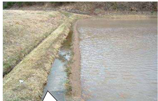
小水路の設置状況
