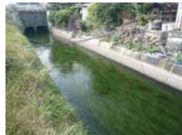
環境配慮対策実施後の水路
