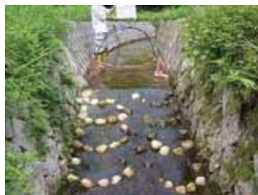
粗石付斜路型魚道の魚類遡上調査
