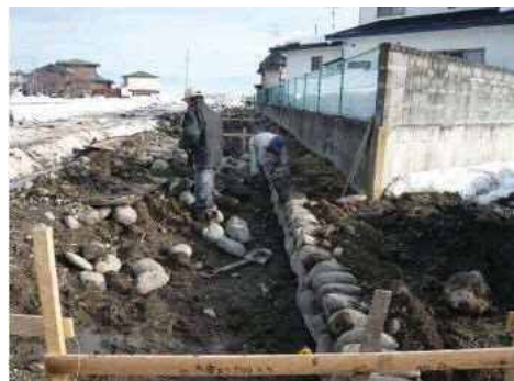
石積み水路の改修
