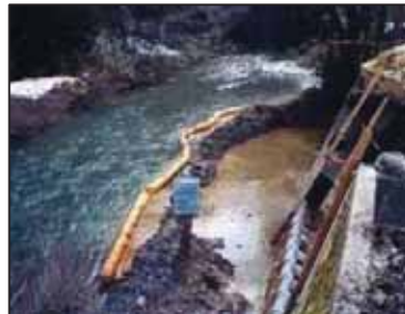
濁水防止フェンスによる抑制
