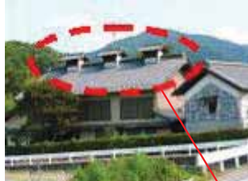
高窓のある切妻屋根
