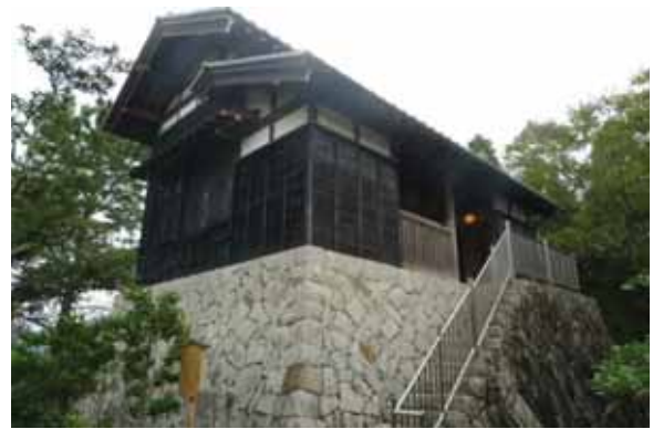
〔保全されている水屋の外観〕
