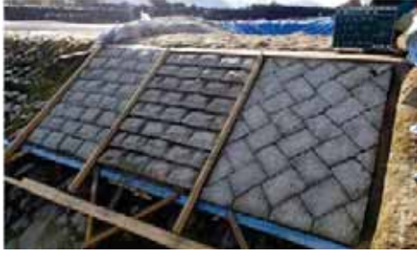
[試験施工状況 (左 No.1、中 No.2、右 No.3)]
