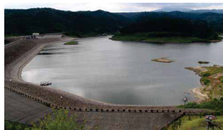
完成写真(造成後11年経過)
