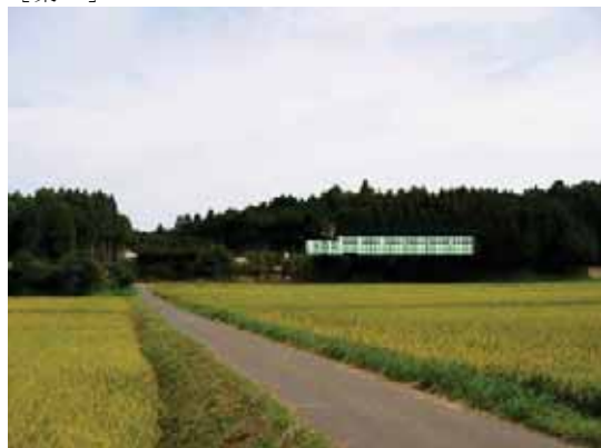
壁②（明るい緑みの灰色）、屋根③（暗い緑）
