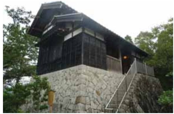
〔保全されている水屋の外観〕
