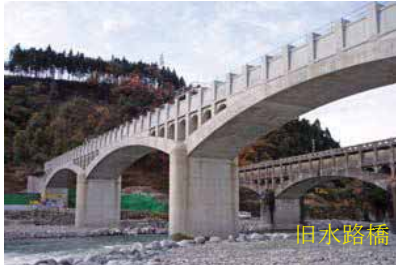
整備前後(新橋、旧橋)
