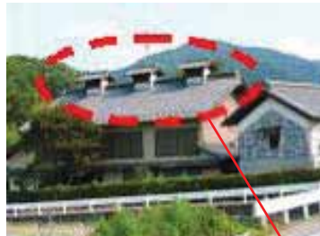
高窓のある切妻屋根
