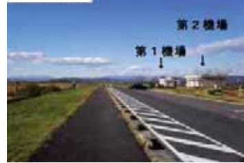
[新与良川橋より]
