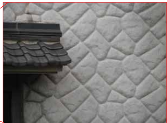
〔デザインコードを活用し設計・施工を行った外壁〕
