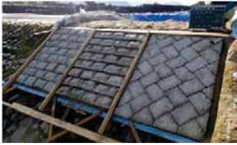
[試験施工状況 (左 No.1、中 No.2、右 No.3)]
