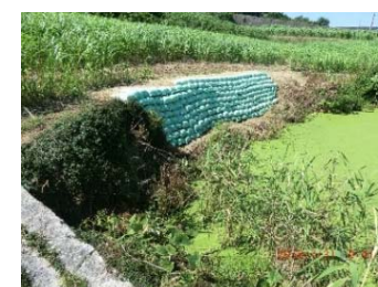
【例⑤】土のうによる崩落箇所の拡大防止
