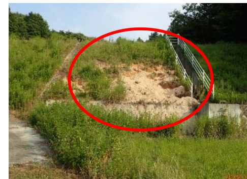
ため池の下流側法面が崩落
