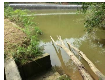
【例④】洪水吐に堆積した土砂や流木等の撤去
