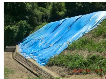
【例①】ブルーシートによる被災箇所への保護
