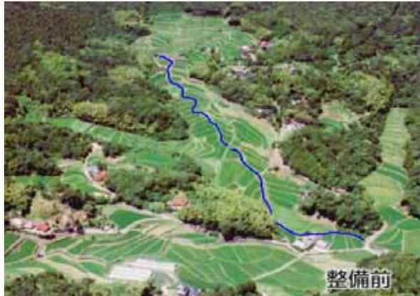
写真-28.3 ほ場整備前
