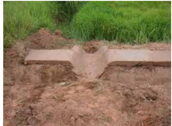
写真 - 29.3 マグホワイトによる排水口の成形
