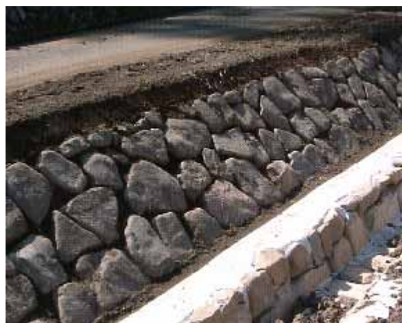
写真-28.14 新たに設置する工事中の石積み水路
