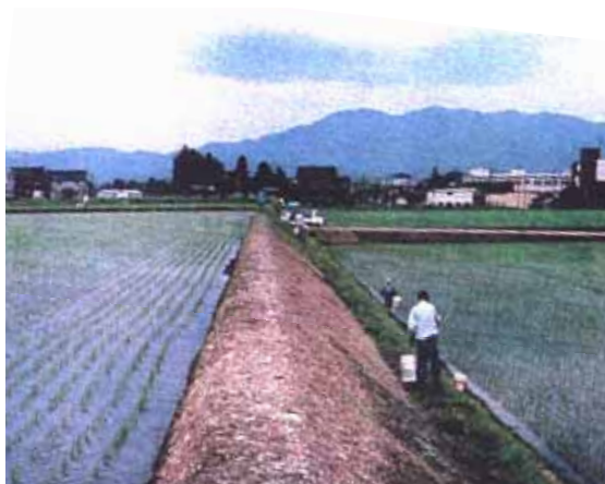
写真-28.7 ほ場整備直後の畦畔法面
