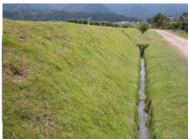
写真-28.8 植栽後の畦畔法面
