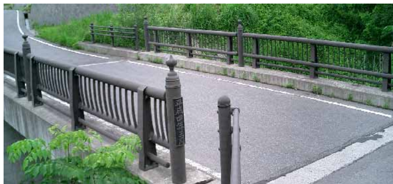
写真-24.10 農道の橋梁
