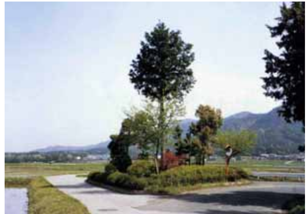
写真-24.7 大樹を保全して整備した交差点
