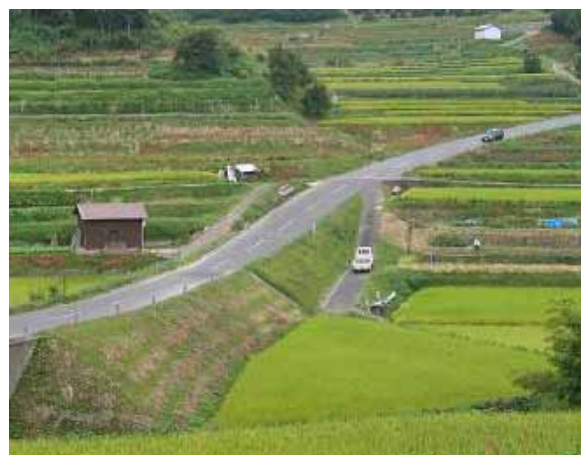
写真-24.4 ガードケーブル設置状況 (外部景観への影響)
