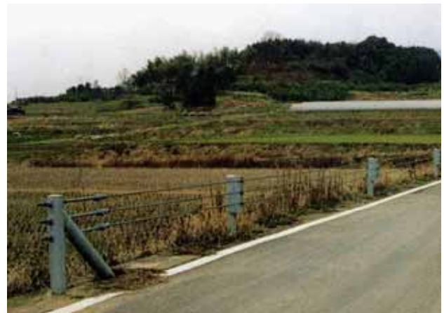
写真-24.3 ガードケーブル設置状況 (内部景観への影響)
