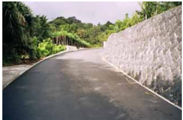
写真-24.2 地元産の石材を利用した擁壁
