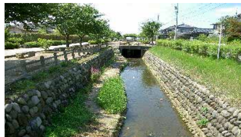
地域の環境との調和に配慮した水路
