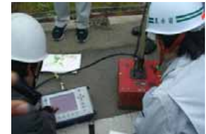
地中レーダによる埋設管調査
