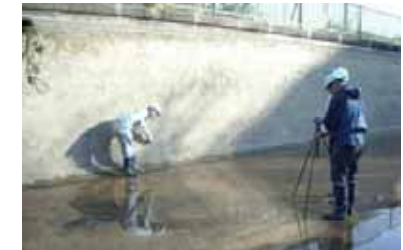
サーモグラフィによる水路壁面調査
