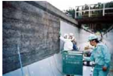
FRPM板取り付けによる断面補強
