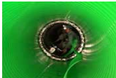
管の更生(SPR工法)による対策
