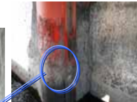
ローラとの摩耗による戸当り損傷
