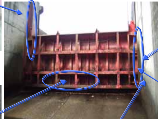
ローラとの摩耗による戸当り損傷
