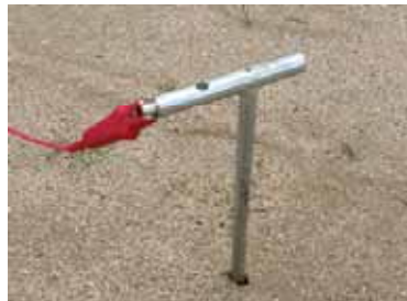
補助接地棒打込み状況
