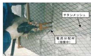
電気防食工法
